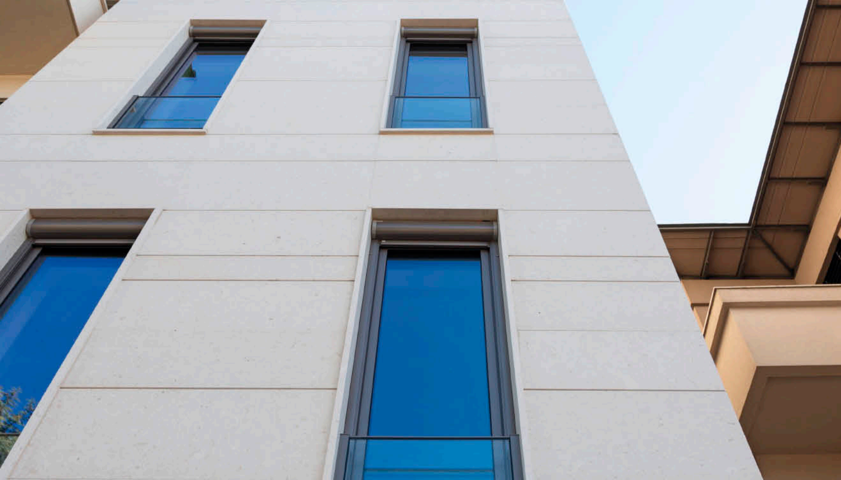
Godina izgradnje / Year of build: 2016 Investitor / Investor: Privatni Sistem / System: Schüco
